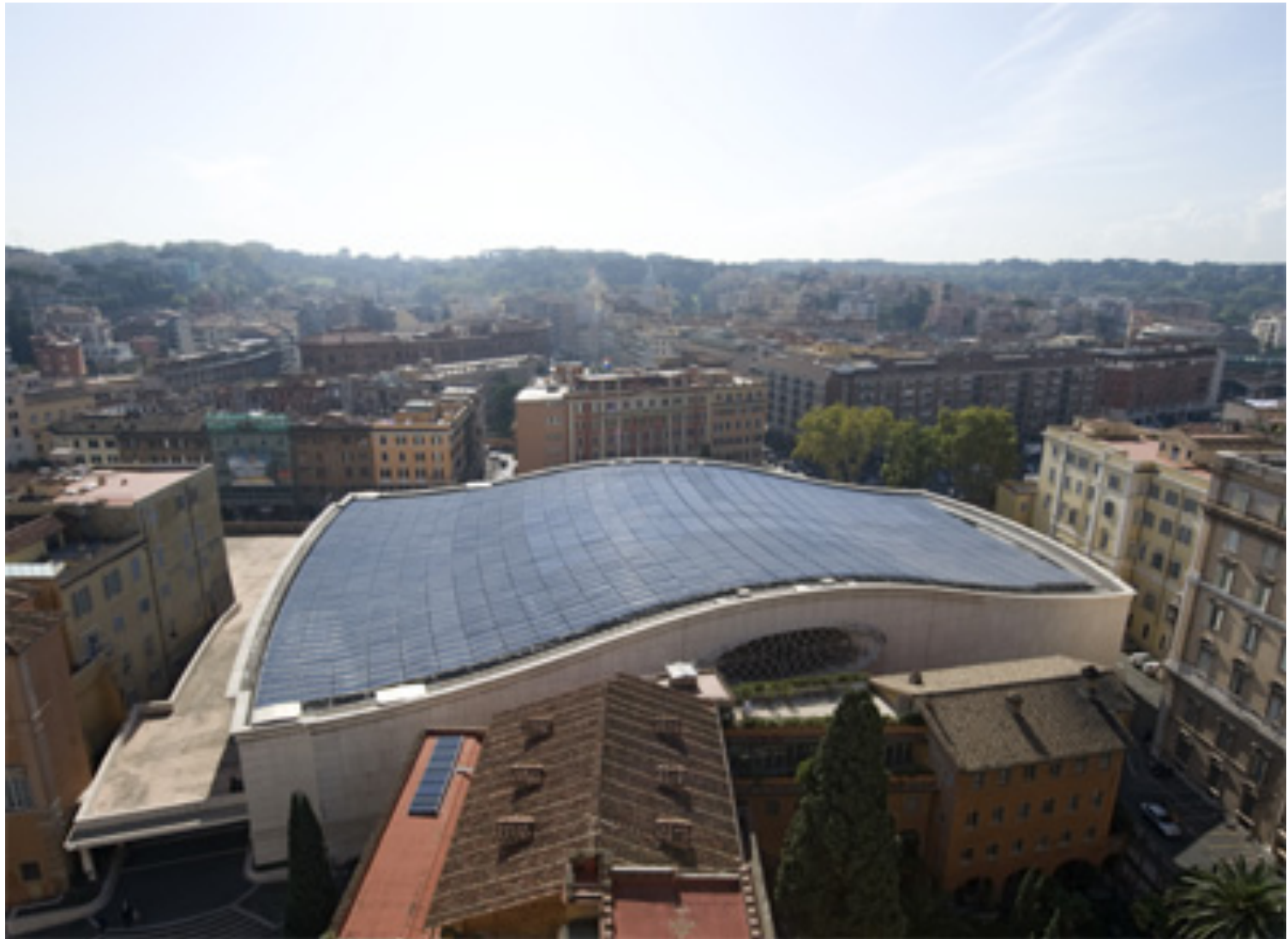
Solarkraftwerk auf der Audienzhalle des Papstes
