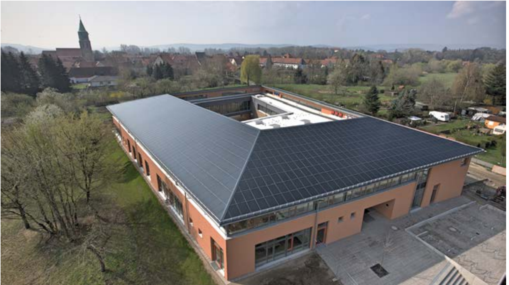
Schule Gronau PV-Anlage
